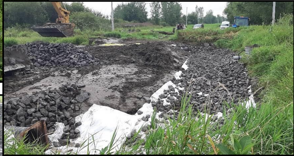
Fosse de sédimentation à la sortie de la station de pompage
