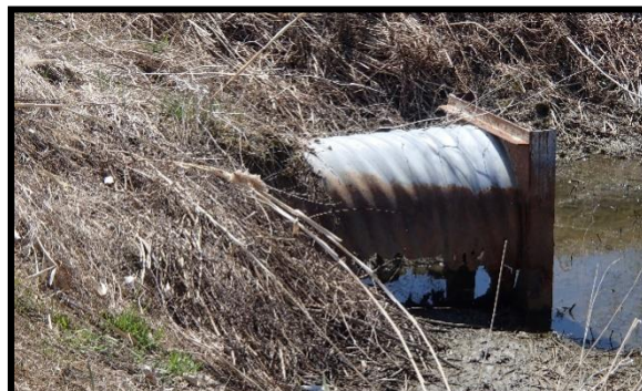
Ponceaux des segments 6 et 7
