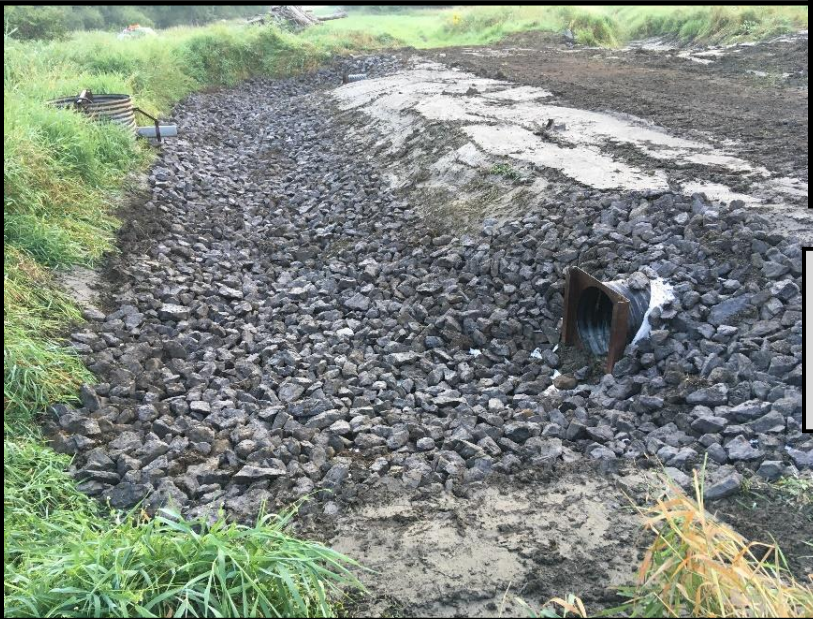
Fosse de sédimentation à la sortie de la station de pompage
