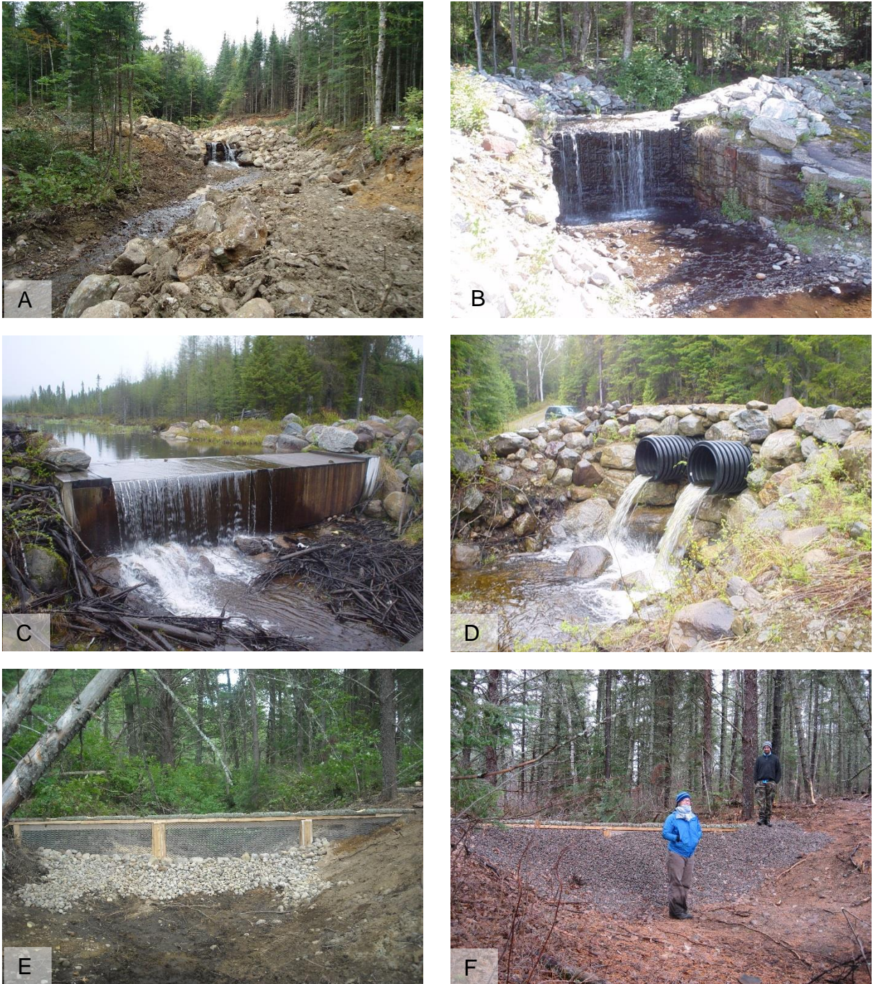
Figure 3.2. Exemples d'obstacles à la montaison du poisson : A) Roches empilées; B) Chute dynamitée; C) Caisson de bois; D) Ponceau chute; E et F) Digue filtrante (structure de bois et grillage en acier inoxydable recouverts de gravier de 1 à 2 cm de diamètre) (suite page suivante).
