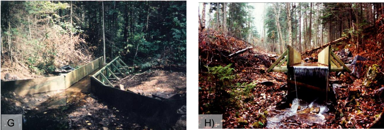
Figure 3.2. Exemples d'obstacles à la montaison du poisson (suite) : G) Dalot en bois (vue amont); H) Dalot en bois (vue aval).
