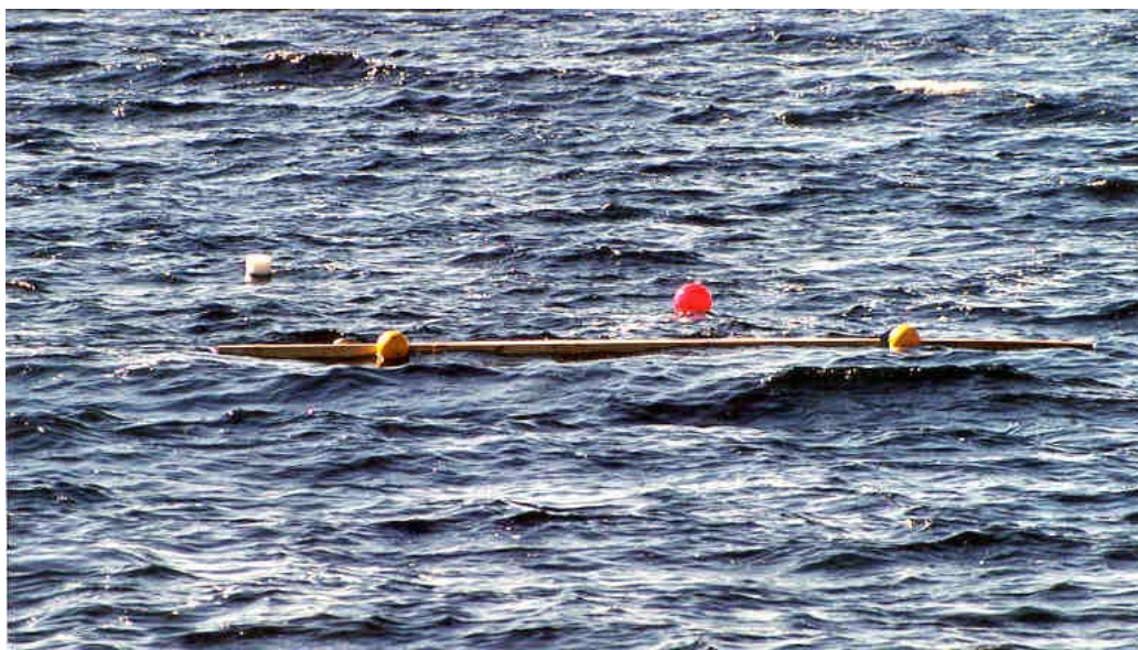
Poutrelle de bois ancrée, servant à l'amarrage lors du dépôt des pierres
