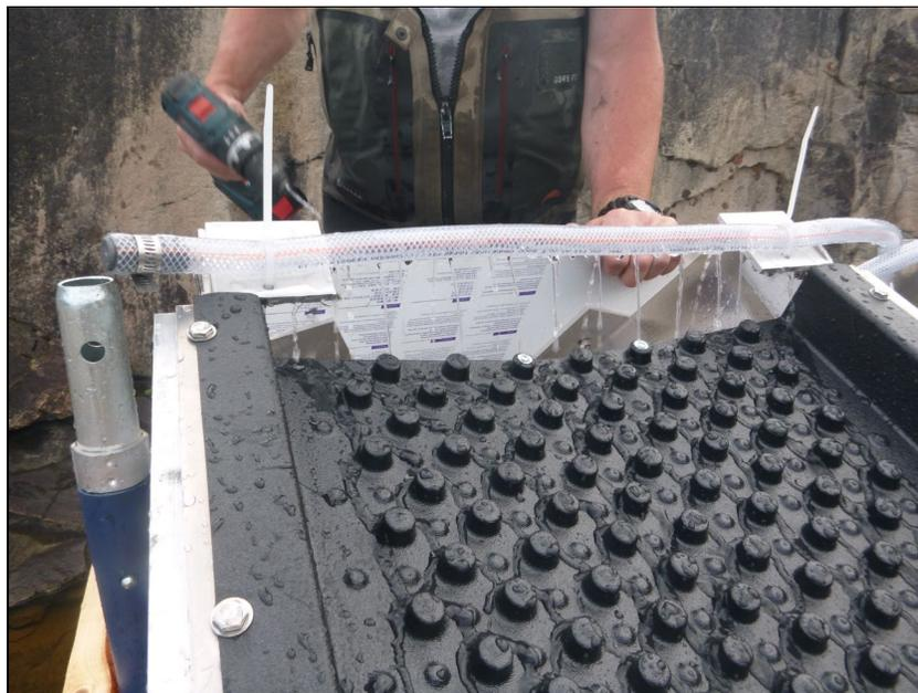
Figure 2 : Substrat de reptation (modèle à plots de Lakeside Engineering) permettant aux anguilles de monter par la passe migratoire
