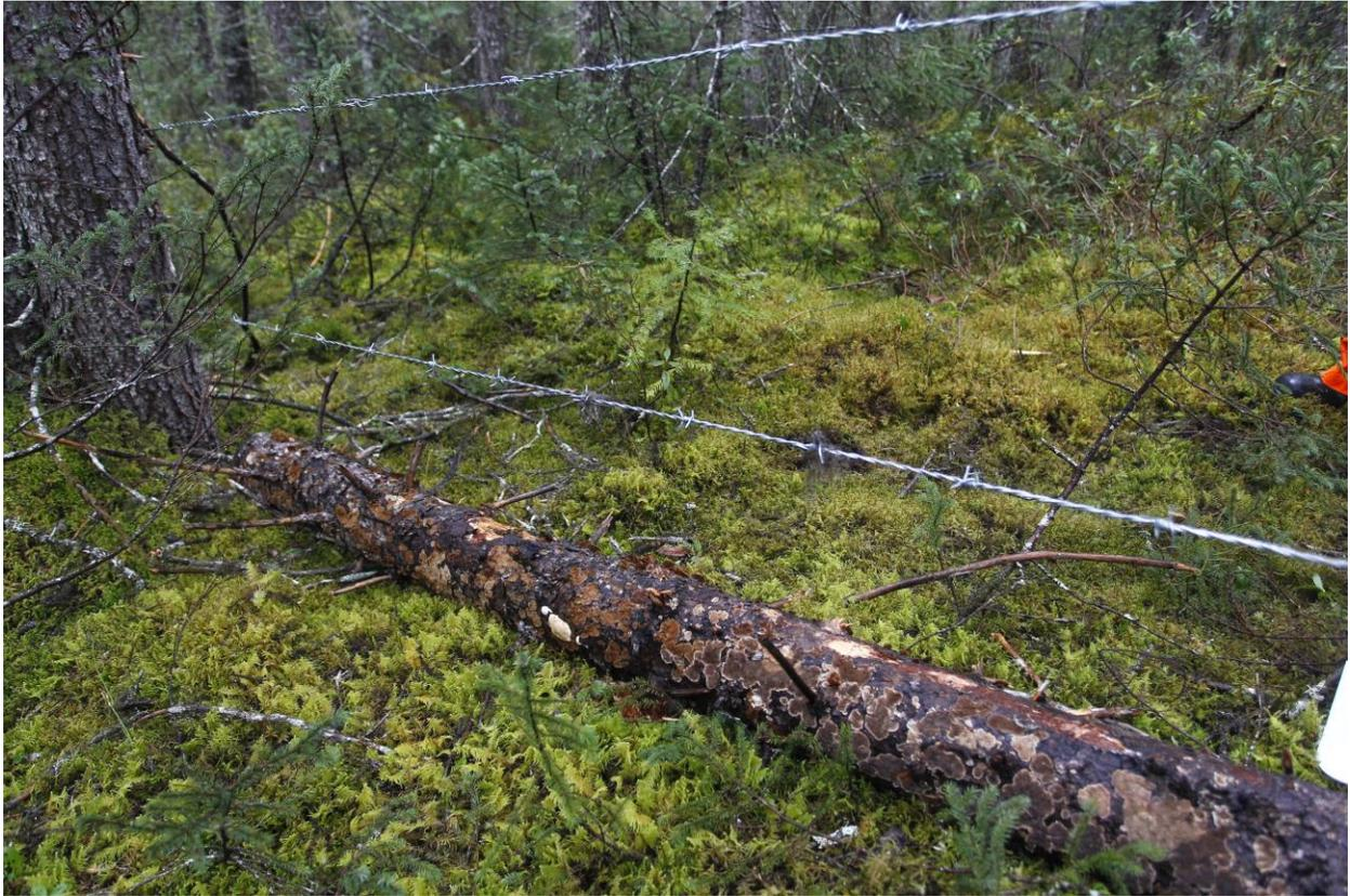
Des arbres sont utilisés pour niveler le sol sous les fils barbelés et éviter que des ours puissent s'introduire dans le périmètre clôturé sans les toucher.
