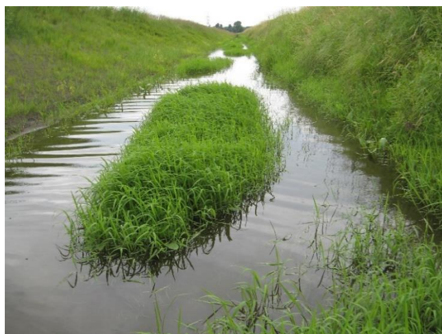
Photo 3. Cours d'eau bonifié, MRC de Brome-Missisquoi, 2019 (Bonification : chenal à deux niveaux et sinuosités)
