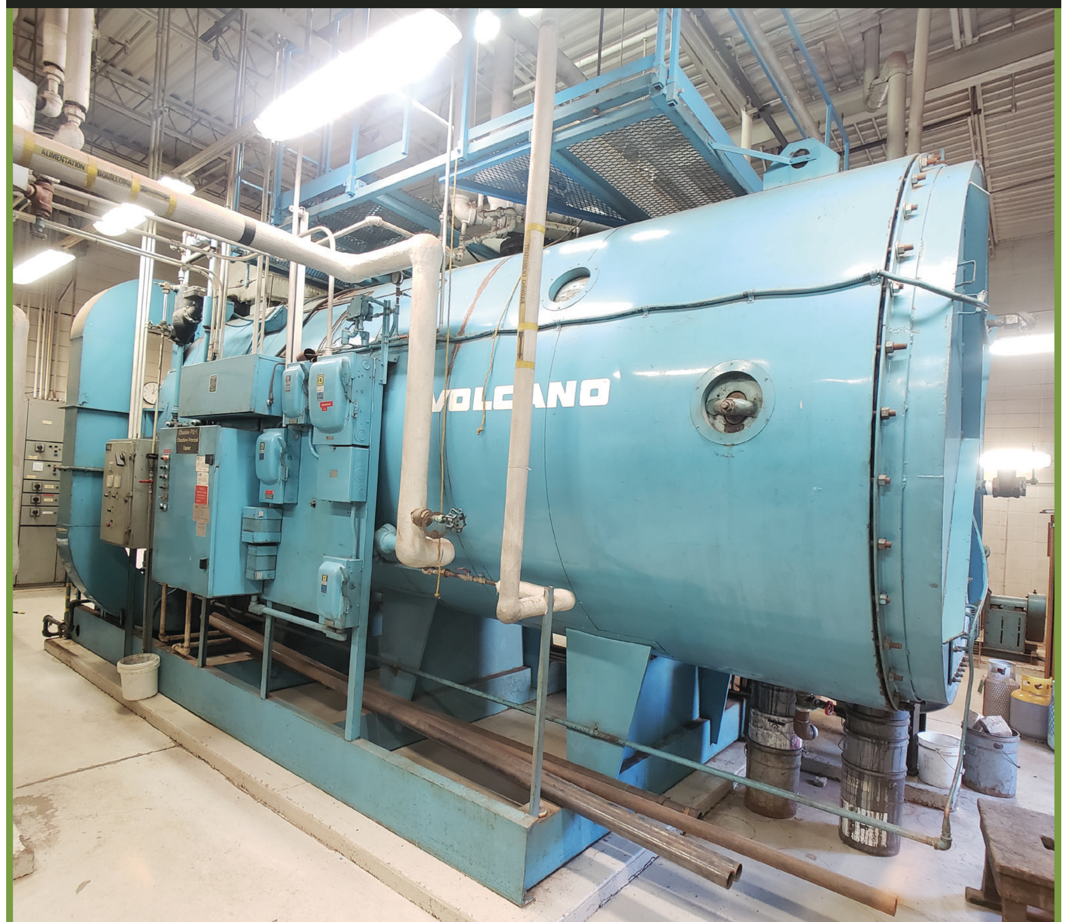
Combustion des débris pour chauffer le complexe administratif et le CSFB en hiver
