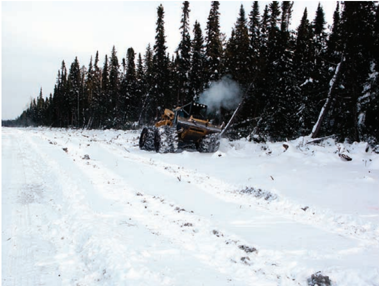
Figure 36. Compactage de la neige le long d'une route pour favoriser la pénétration du gel.
