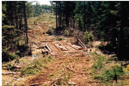
Figure 44. Structure temporaire de traversée de cours d'eau avec protection latérale et pontage contre les dommages aux berges et l'entrée de débris dans le cours d'eau.
