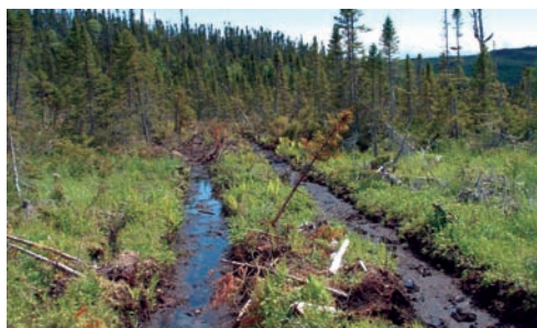
Figure A2. Traces de machines dans un sol organique.
