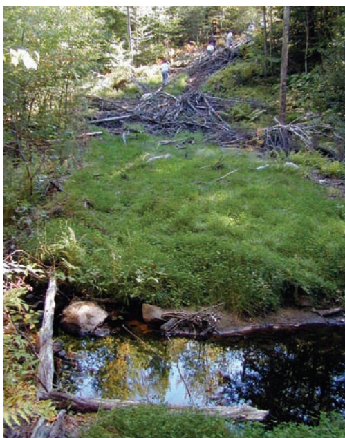
Figure 48. Traversée de cours d'eau remise en état par l'ensemencement des berges (au premier plan). Fossés transverses et débris utilisés dans le sentier de débardage pour réduire la canalisation de l'eau de ruissellement (arrière-plan).
