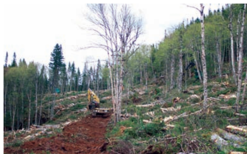
Figure A5. Construction d'un sentier avec une pelle mécanique dans un terrain à pente forte dans le centre de Terre-Neuve.
