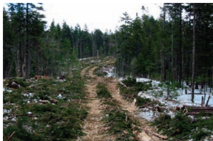
Figure 45. Protection de sols fragiles à l'aide d'une double épaisseur de tapis de branches dans un sentier de porteur.
