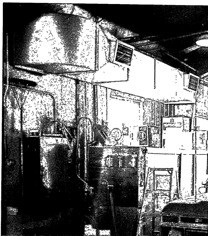
Figure 18. Embouchures du système de ventilation.
