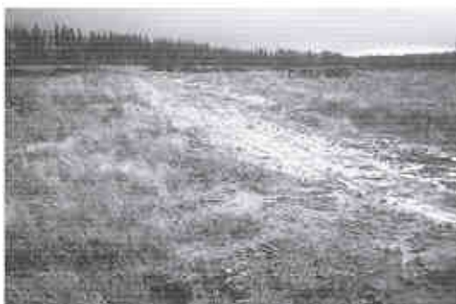
Figure 3. Chemin construit en hiver par décapage de la couche d'humus.
