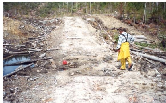
L'érosion transversale est souvent causée par l'absence d'un tuyau de drainage naturel sous la surface de roulement des chemins mis en forme.
