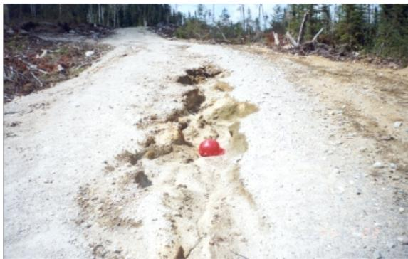
Ce type d'érosion se produit sur la surface de roulement, dans le sens de la pente. Il s'agit généralement d'un ravinement causé par un mauvais profilage de la surface de roulement ou par la présence de bourrelets en bordure de celle-ci, qui ne permet pas l'évacuation régulière de l'eau. Il peut également s'agir d'un affaissement de la route au-dessus d'un ponceau causé par l'effondrement de ce dernier ou par un mauvais compactage.
