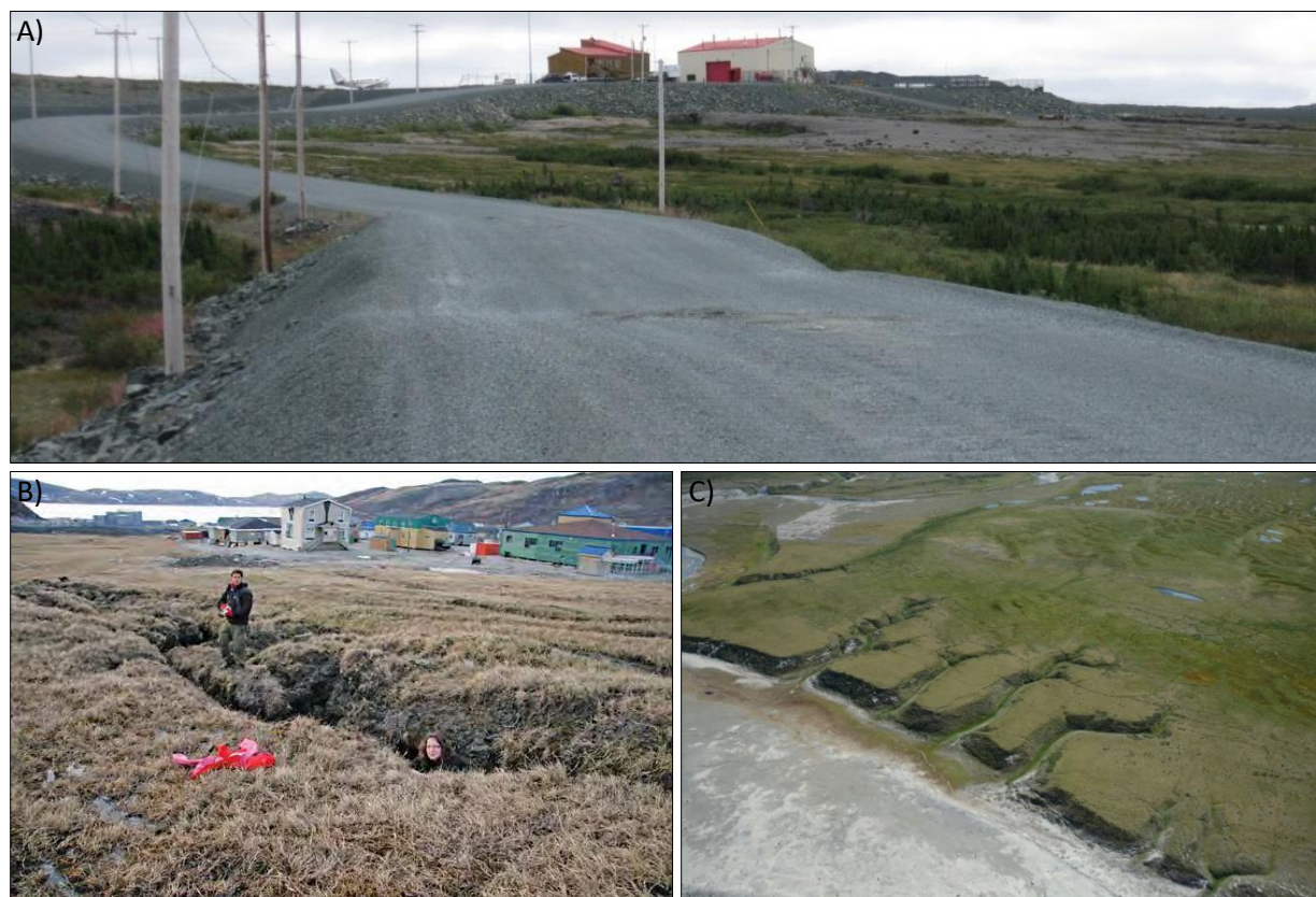
Figure 12: A) Affaissement thermokarstique visible sur la route d'accès à l'aéroport d'Umiujaq. B) Phénomène de thermo-érosion initié dans les ornières d'un véhicule lourd à Salluit. C) Phénomène de thermo-érosion dans un réseau de polygones à coins de glace, fjord de Sugluk.
