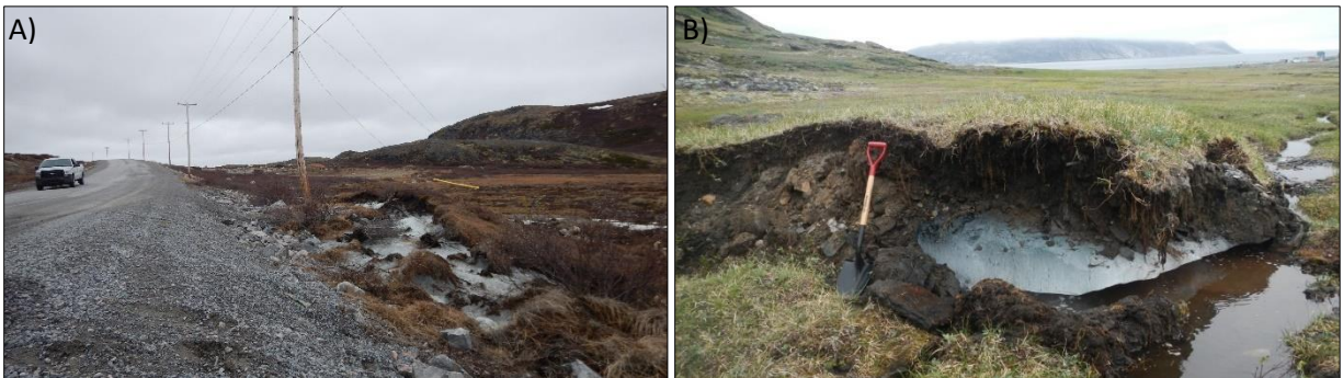
Figure 11: A) Butte saisonnière à noyau de glace située le long de la route d'accès à l'aéroport de Kangiqsualujjuaq. Le poteau électrique est courbé. B) Butte saisonnière à noyau de glace localisée le long de la paroi rocheuse au sud de la communauté de Kangiqsujuaq.
