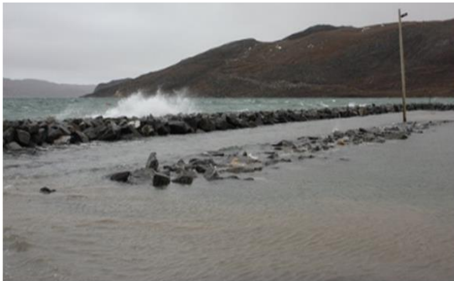
Figure 76 : Surcote et inondation à Salluit
