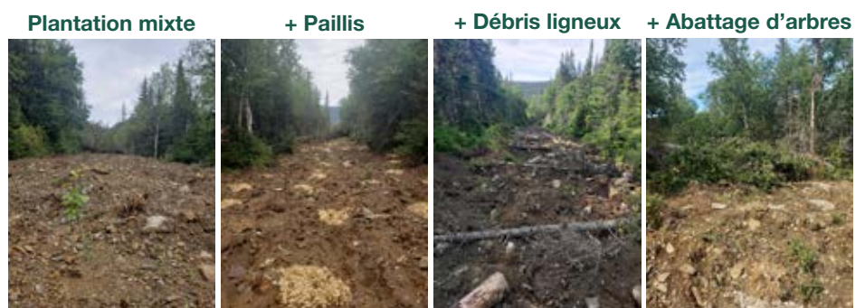
Figure 1. Techniques de restauration utilisées sur les chemins du parc national de la Gaspésie.
